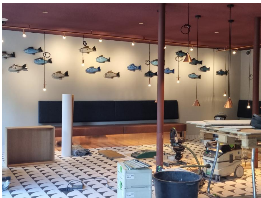
Utsikt mot nya restaurangdelen genom en ny öppning i skiljeväggen.
